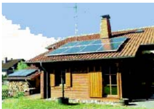
Impianto fotovoltaico collegato alla rete
