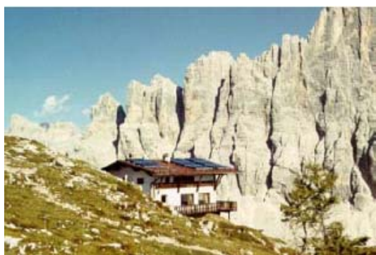
Impianto fotovoltaico per utenza isolata
